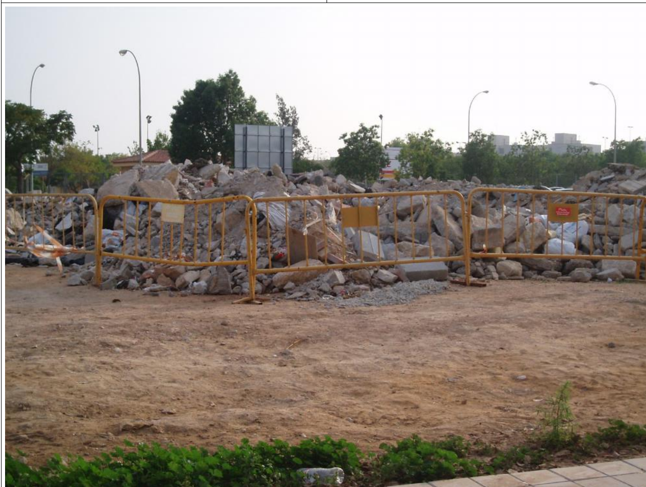
Estado del solar situado junto al CEIP Eusebio Sempere
